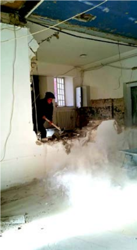
Pastor Touché reisst die Wand zur künftigen Küche ein.
