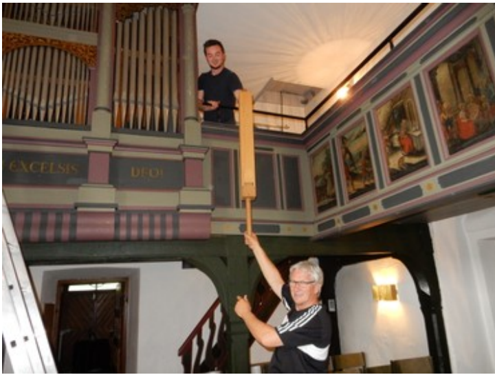
Die ersten Holzpfеifen werden ausgebaut.
